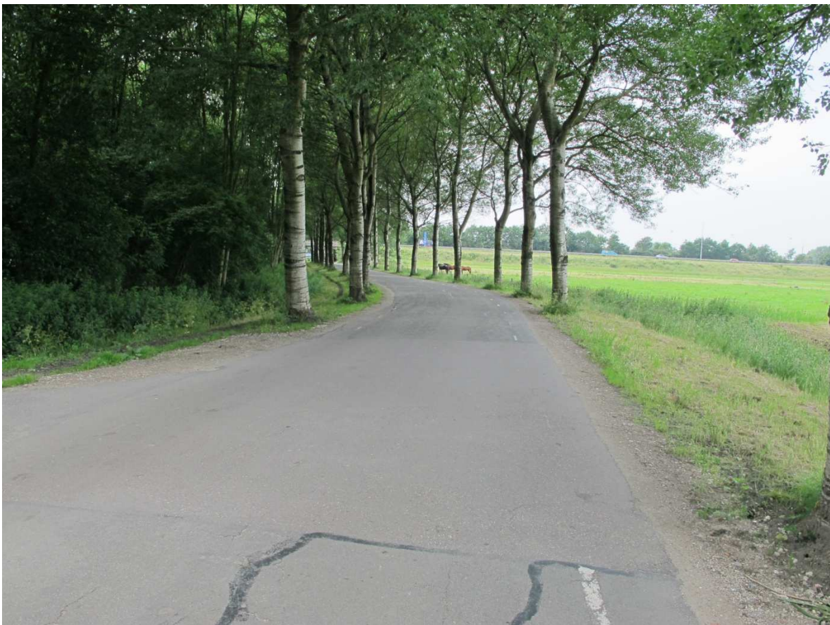
30) Vanaf 't Spijk richting boorlijn
