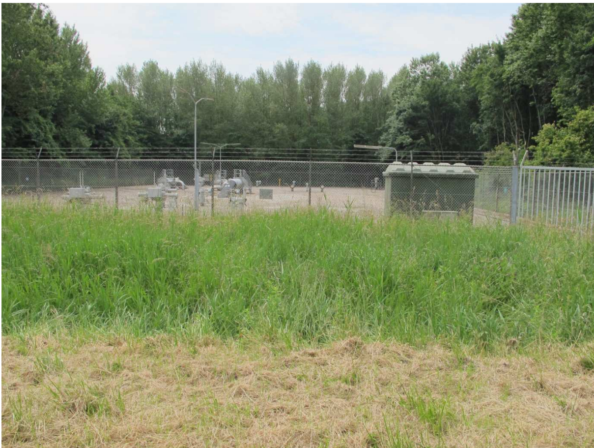
18) Gasuniestation wat aan de achterzijde gekruist wordt
